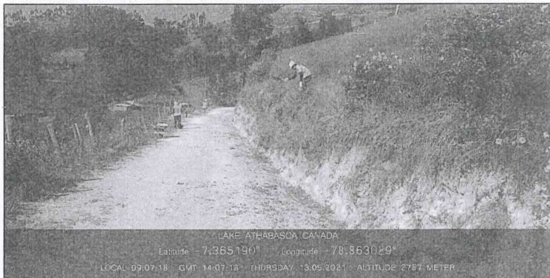
FOTO N° 11: Roce y limpieza.
