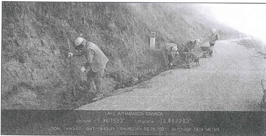
Foto N° 02: Limpieza de cunetas.
