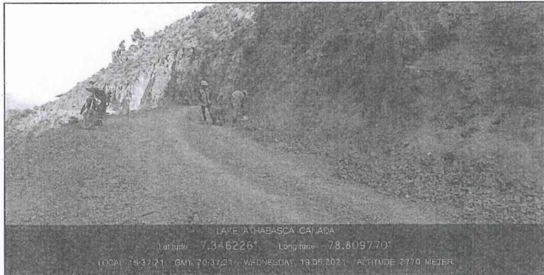
Foto N° 07: Remoción de derrumbes.
