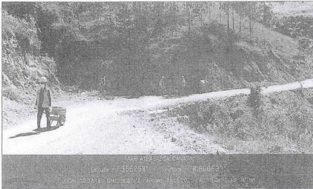
FOTO N° 09: En la imagen se observa que se ha realizado los trabajos de limpieza de badenes y derrumbes, para así poder dar transitabilidad.
