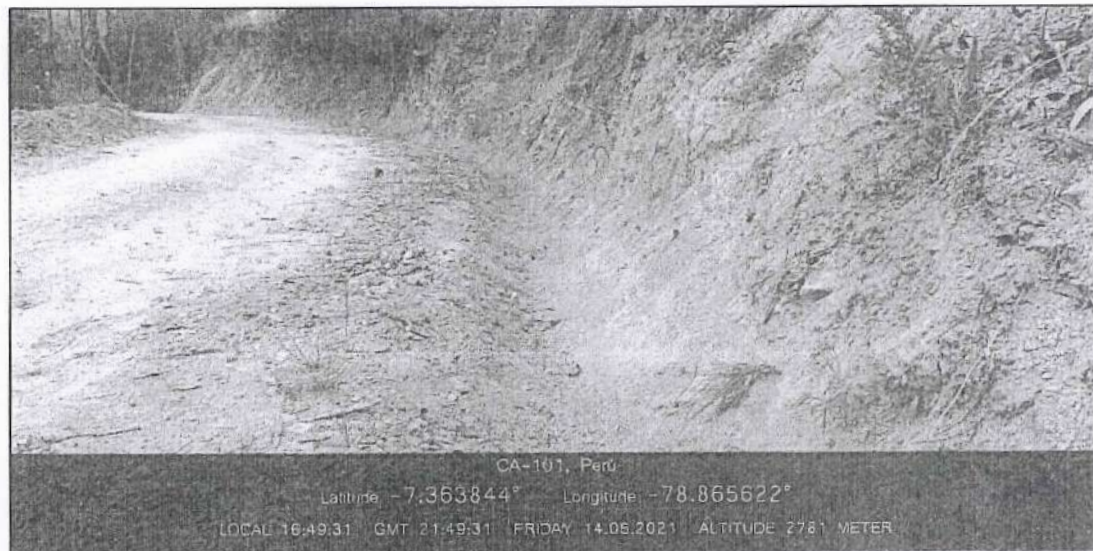
Foto N° 08: Remoción de derrumbes (después)
