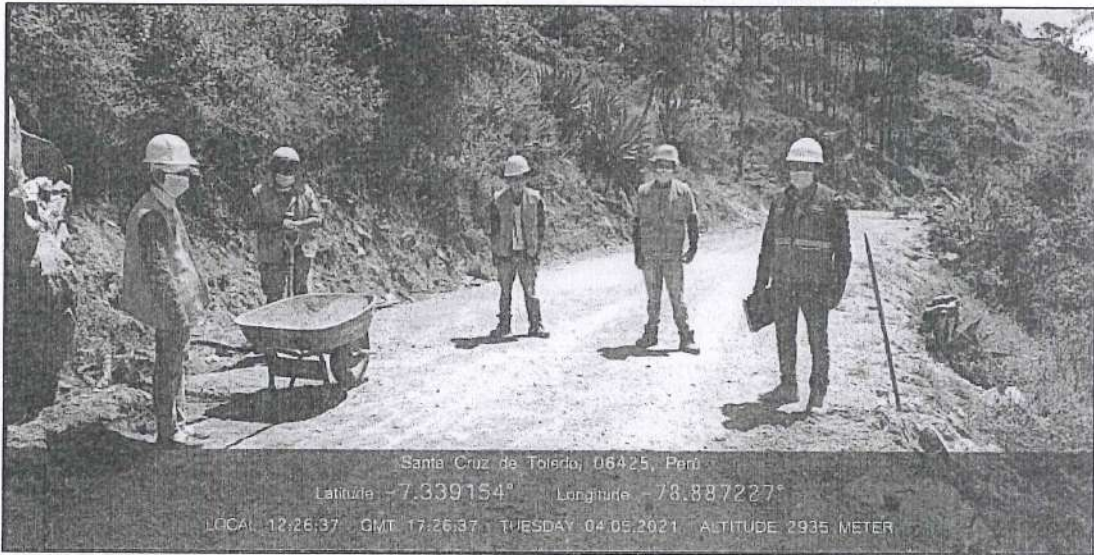
FOTO N° 14: Supervisión por parte de monitor de Provias Nacional.
