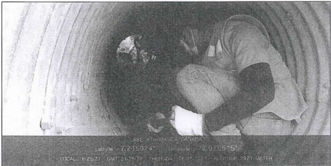
FOTO N° 10: Limpieza de alcantarillas.
