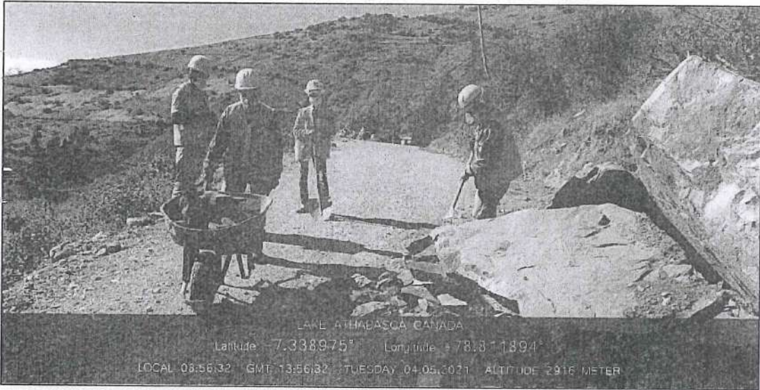
Foto N° 01: Trabajadores picando y retirando obstáculos dentro de la vía.
